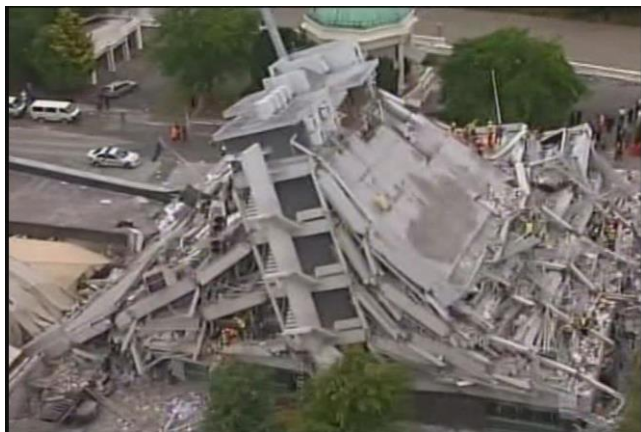
Loše odabran konstrukcijski sistem, Christchurch, New Zealand, februar 2011.
