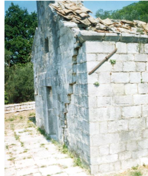
Oštećenja na crkvi Sv. "Ilija" u Lastvi Grbaljskoj, crnogorski zemljotres 1979.
