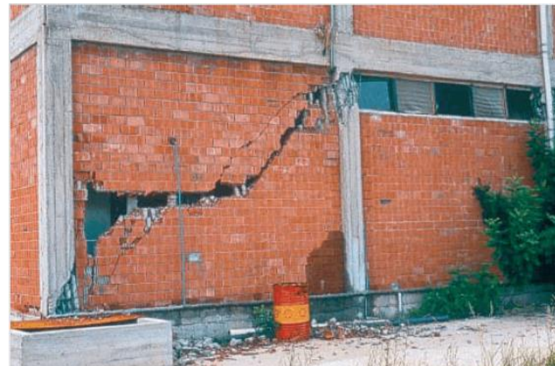
Izbjeći krutu vezu fleksibilnog zida i ispune od opeke
